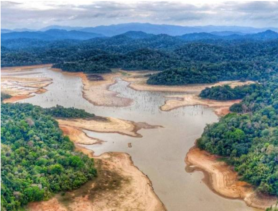
Keadaan Empangan Muda di Kedah yang berada dalam keadaan kritikal.
