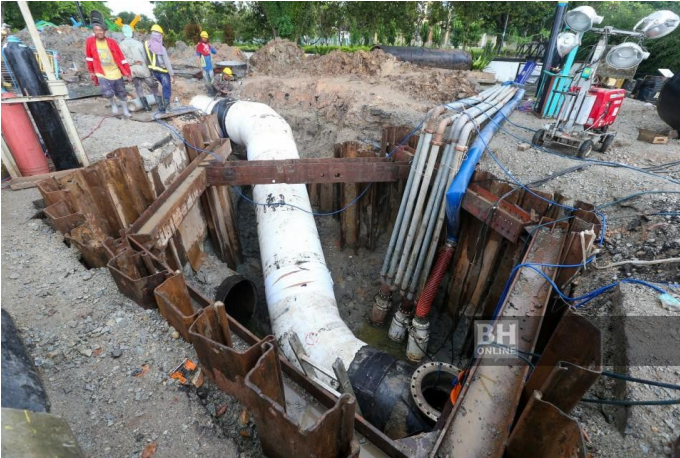
Kerja pemasangan paip 1200 milimeter (mm) baharu sepanjang 180 meter di Jalan Permatang Pauh. - NSTP/DANIAL SAAD
