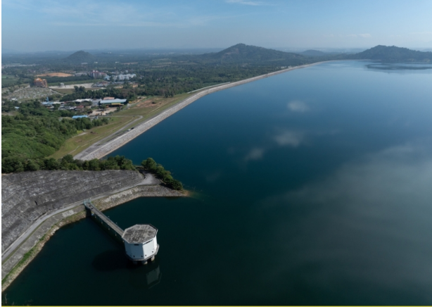
PBAPP : EMPANGAN MENGKUANG YANG DIPERBESARKAN / EXPANDED MENGKUANG DAM (2024)
