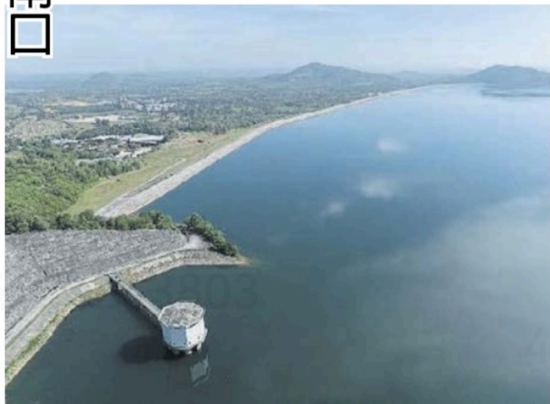
孟光水坝急需建泵站, 增加第二个补水来源, 同时升级管道, 增加释放净水的能力。(取自槟供水机构面子书)
