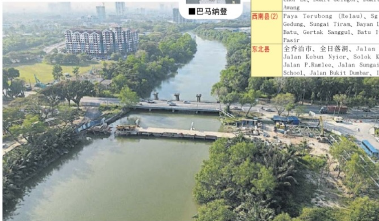
■位于威省的北賴河跨河管道计划已完成70%，将在4月25日完成最后连接工程。
