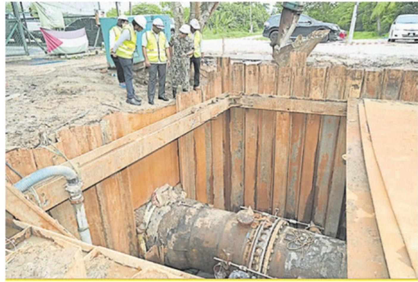
■ 槟州供水机构将更换在双溪赖滤水厂附近的彭加兰登榜路一段水管上的1.2公尺故障阀门。
