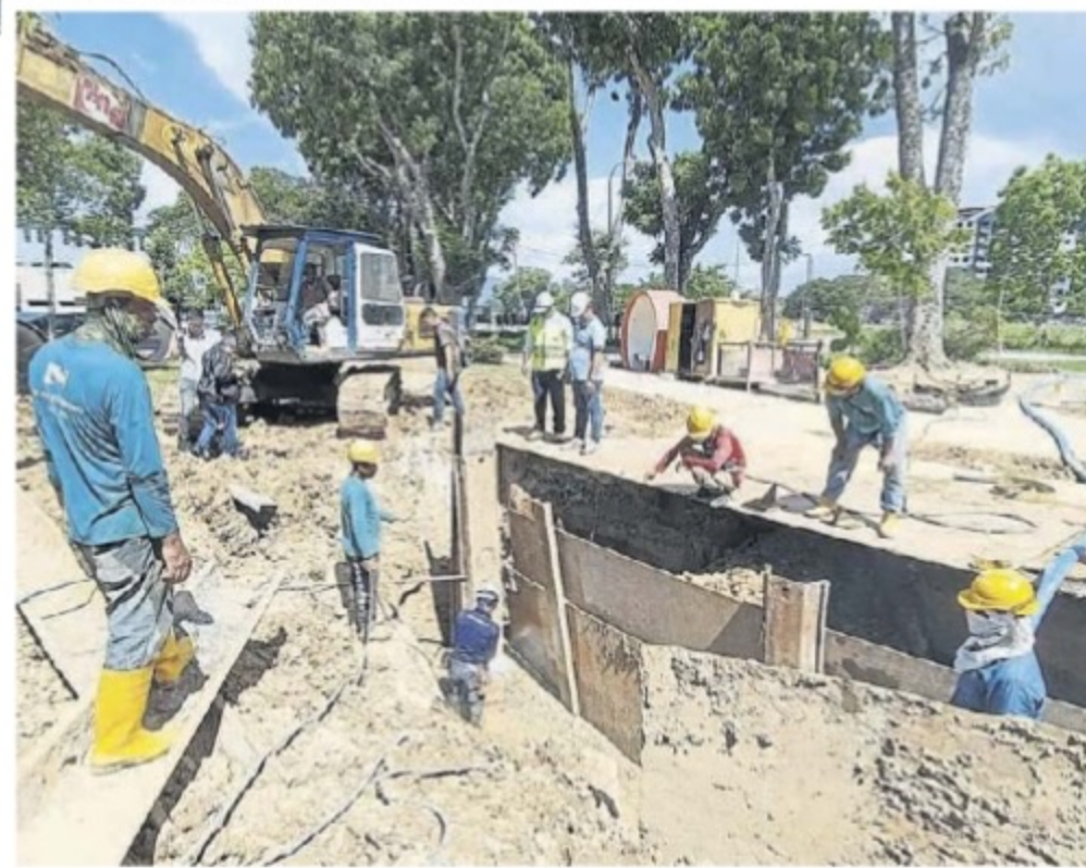
■北賴河跨河管道工程如火如荼進行，工作人員都在謹慎工作。
