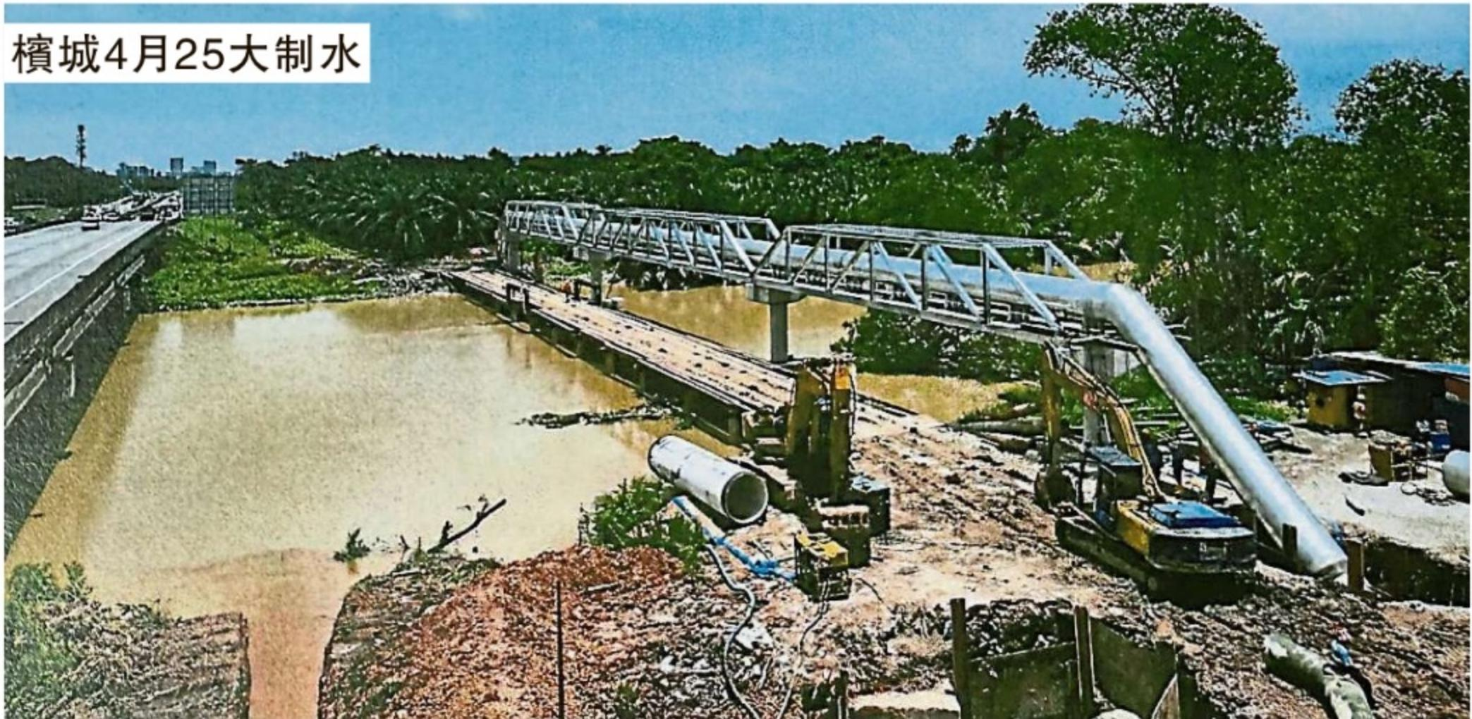
位于甘榜直落的北赖河新跨河管道也将进行最终接驳工程。（翻拍槟州水供机构图册）
