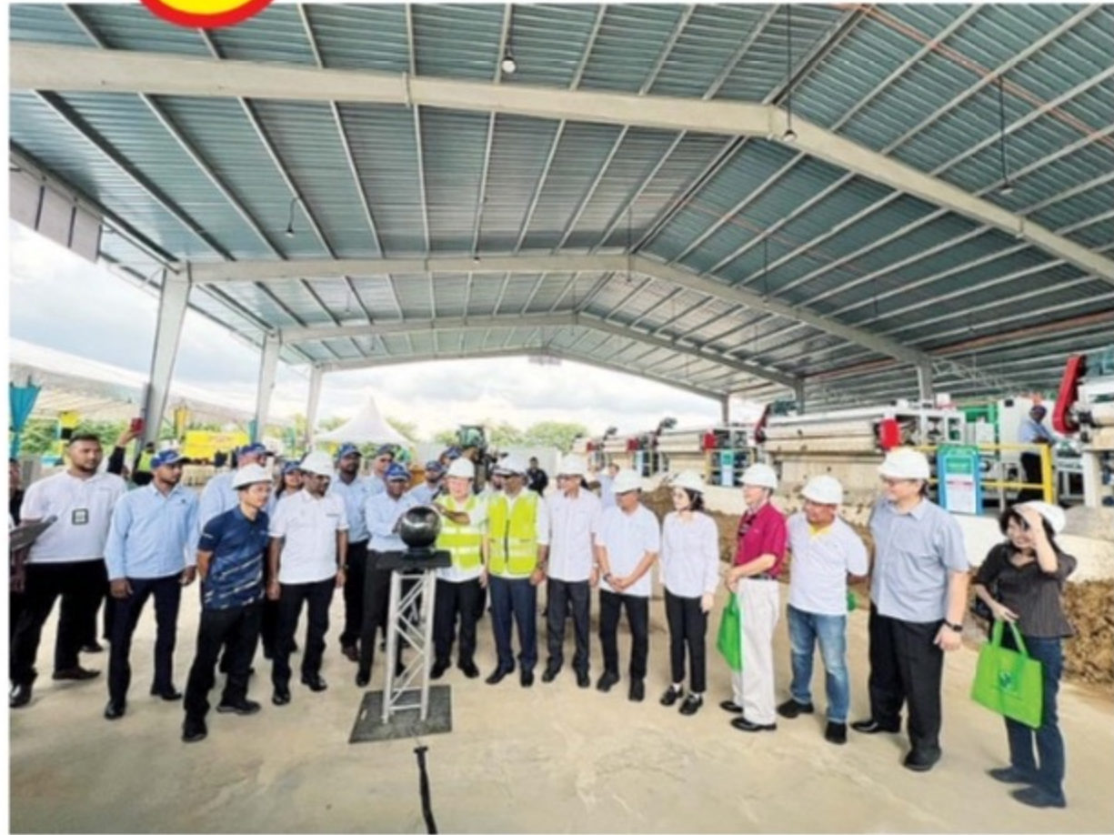
曹观友为槟州供水机构双溪赖滤水站污泥脱水处理中心主持开幕启用。
