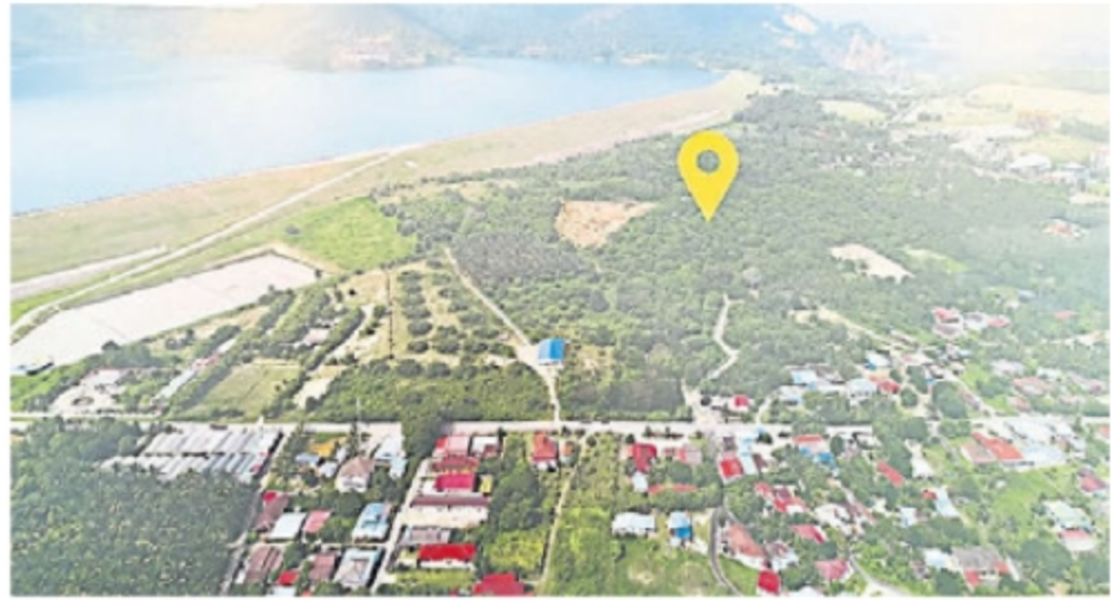
耗资2亿5000万令吉的孟光水坝滤水厂与孟光水坝的距离仅550公尺。
