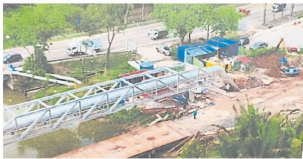
河跨河管道最后连接及管道修复工程施工情况。
