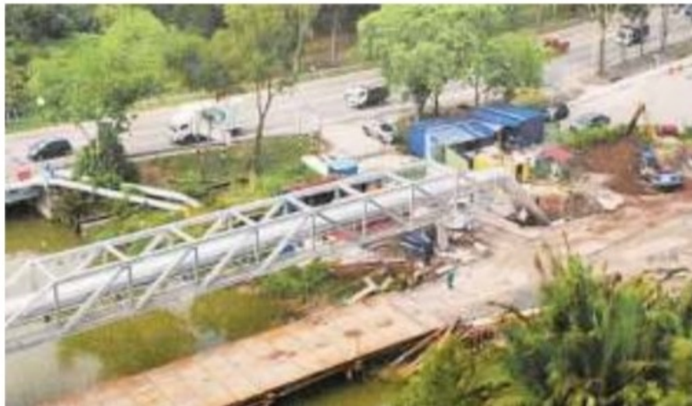
檳州供水机构将在水供中断当天，启动新北赖河跨河输水管衔接工程。
