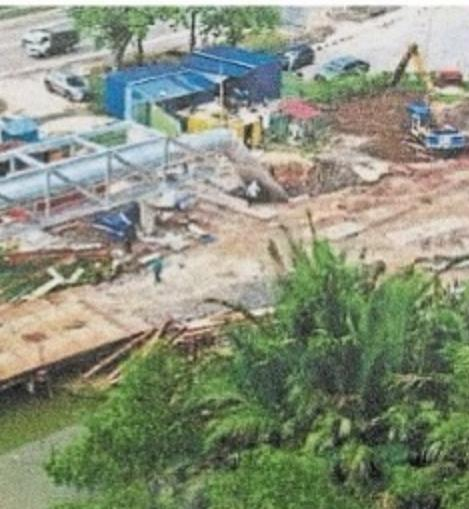
▲吸取了之前北赖河河底水管爆裂后，工作人员很难在河底展开修复的经验，这次的新水管是直接建在河面上，就算日后水管爆裂也更容易修复。
