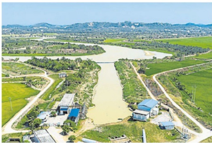
■威北拉哈甸取水口的河流水位，连续19天低于2公尺水平。
