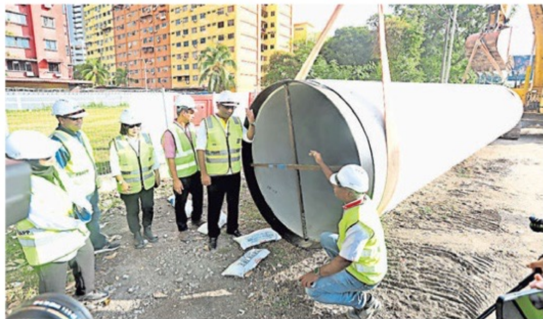
■ 承包商已如火如荼在日落洞苏洛东姑路展开铺设1.8米水管工程。
