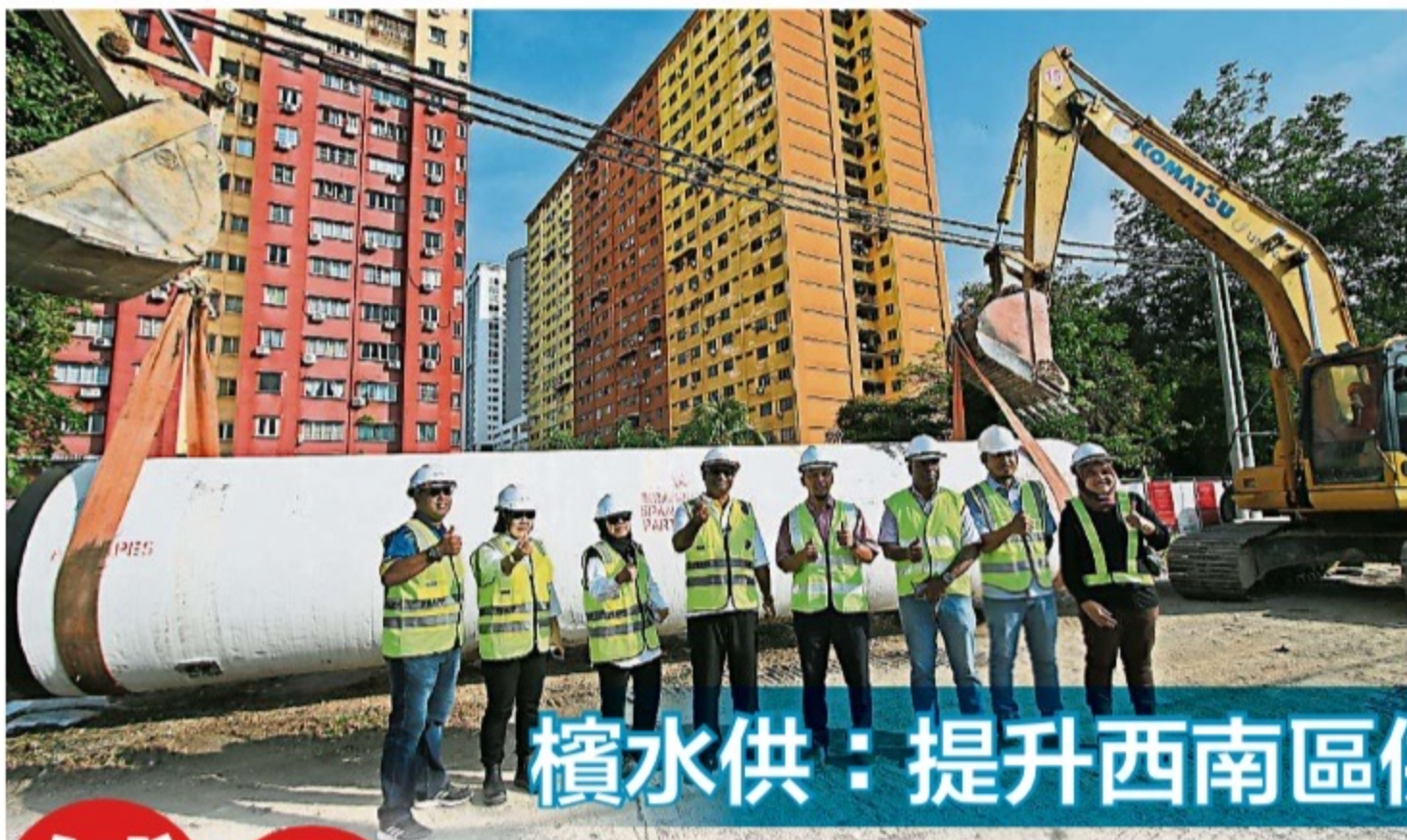
巴马纳登（左四）在工程负责人员陪同下，到工地视察新输水管铺设工作的进度。（林晓慧摄）
