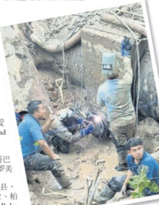
■维修团队展开焊接维修工程。
