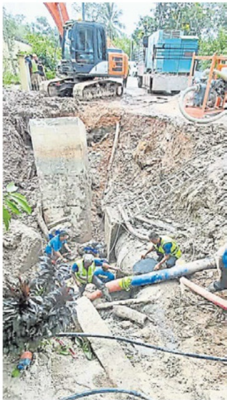
■ 维修团队正准备展开焊接工程。
