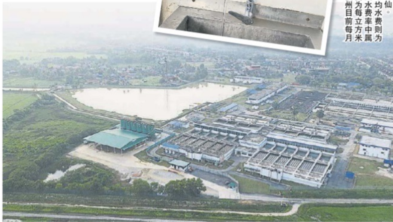
■檳供水机构计划在威省兴建4座新滤水厂，图为现有的双溪赖滤水厂。
