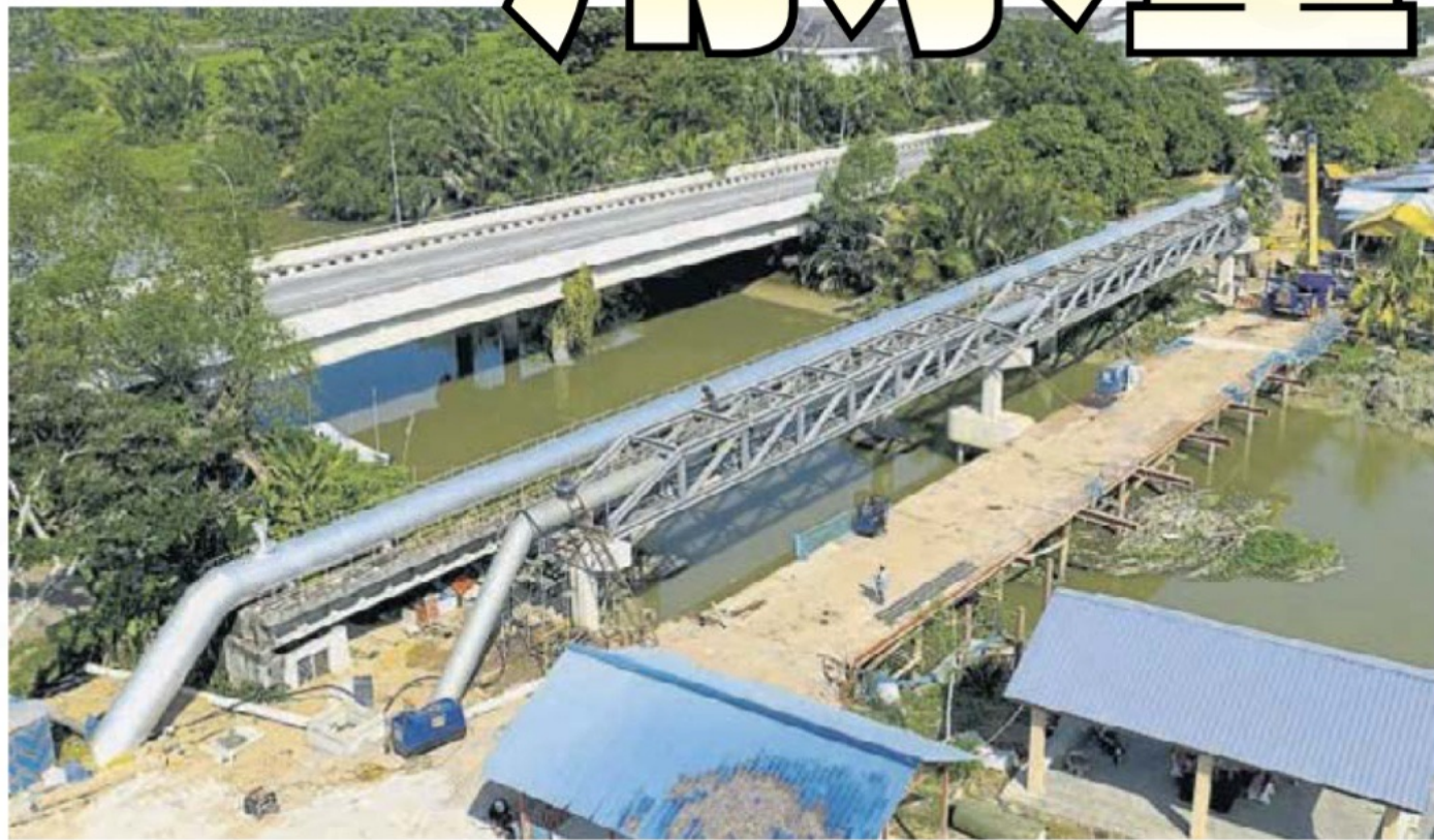
■ 檳供水机构将为第二条北赖河跨河管道, 进行最终连接工程。
