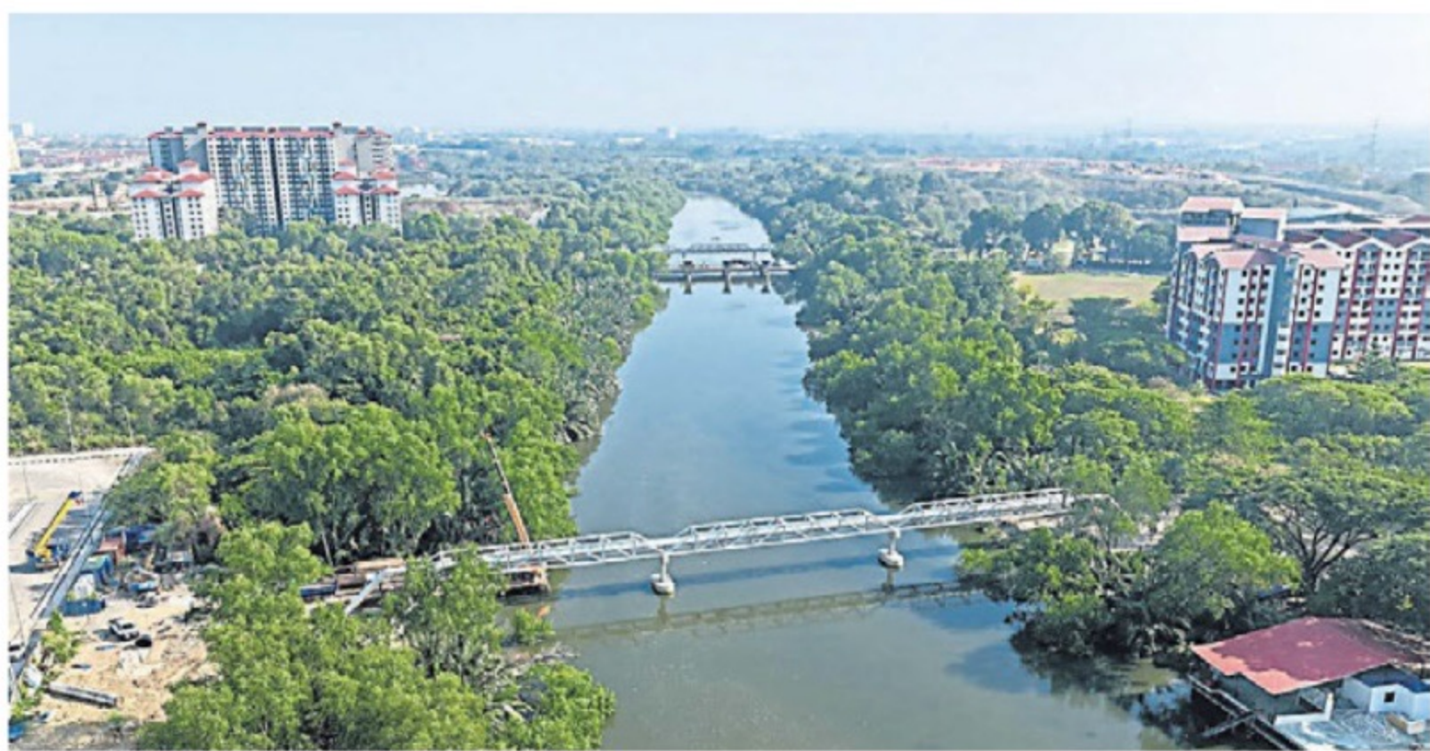
■北赖河跨河管道计划宣告完成。
