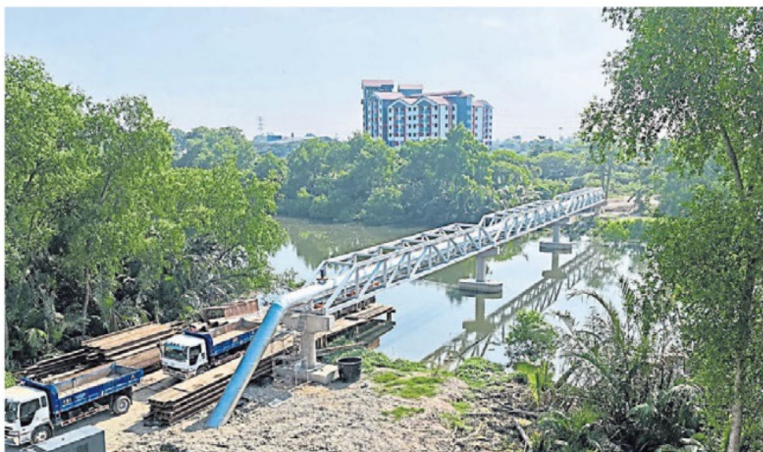
■接驳工程。跨越北赖河的水管，已在上周日完成
