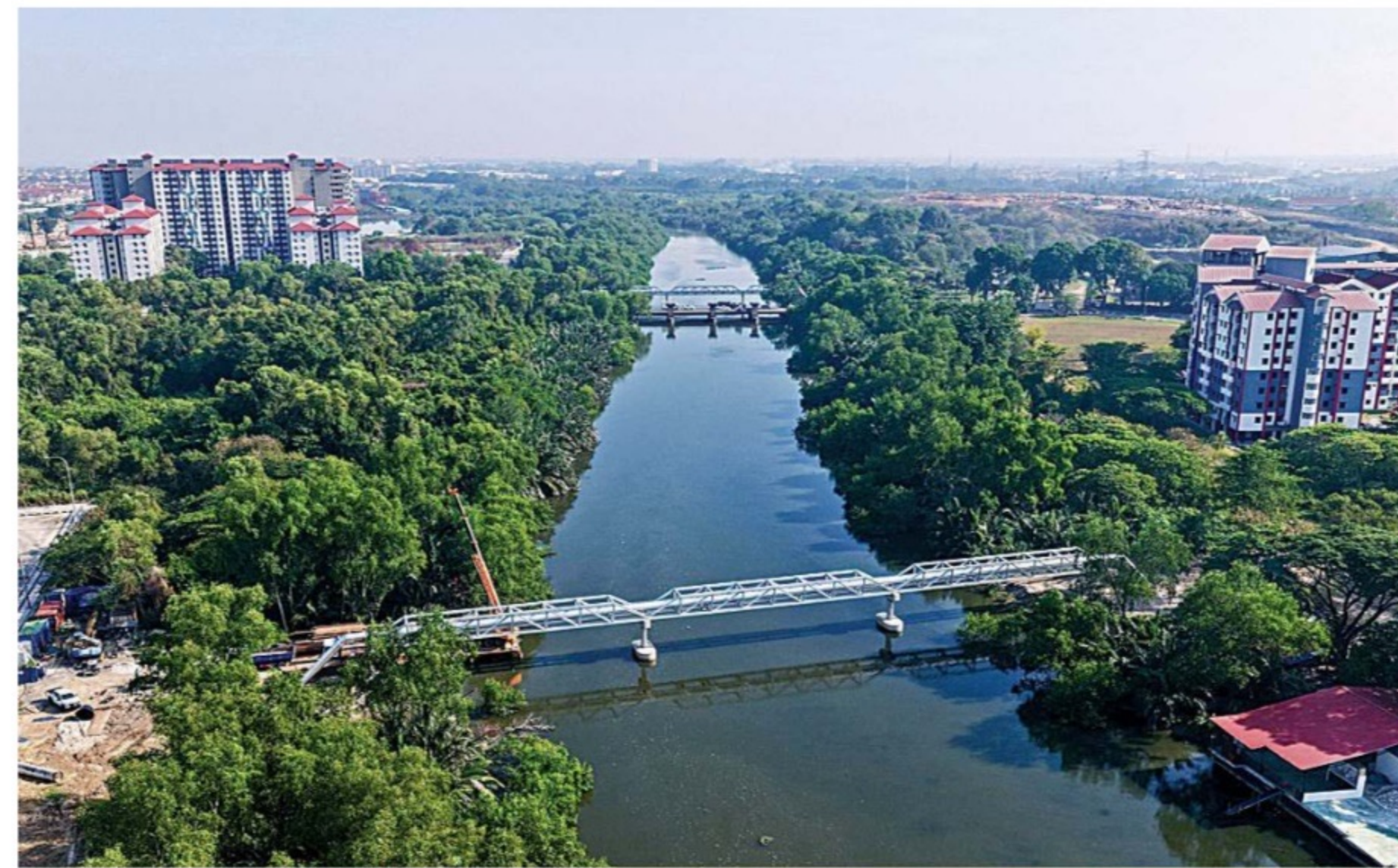
第三条北赖河跨河管道的最终接驳工程已经在 4 月 26 日完成。
