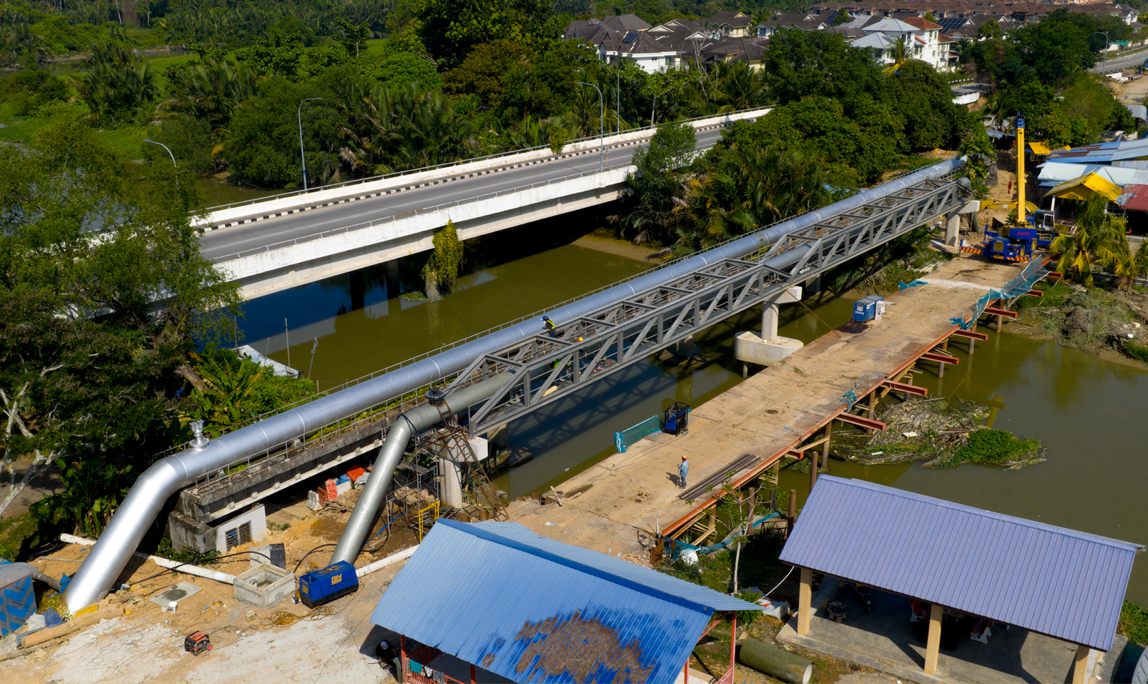
28 - 29 Januari 2026 | Kerja-kerja penyambungan akhir untuk Saluran Paip Penyeberangan Sungai Sungai Perai Ke-2. 28 - 29 January 2026 | Final connection works for the second Sungai Perai River-Crossing Pipeline.
