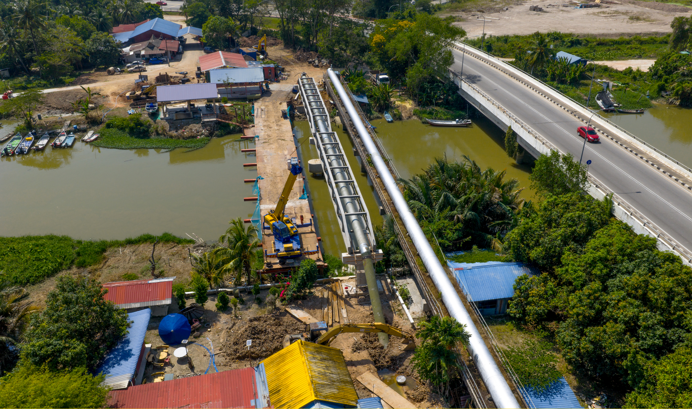
28 - 29 Januari 2026 | Kerja-kerja penyambungan akhir untuk Saluran Paip Penyeberangan Sungai Sungai Perai Ke-2. 28 - 29 January 2026 | Final connection works for the second Sungai Perai River-Crossing Pipeline.
